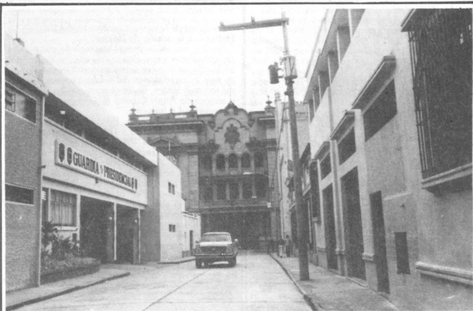
Vista de los fondos del Palacio Nacional de Guatemala. A la derecha, la Casa Presidencial, y a la izq. el anexo de la Guardia Presidencial. En este último edificio se encuentran ubicadas las principales oficinas del organismo presidencial de inteligencia acusado de seleccionar a las víctimas de los asesinatos políticos.
