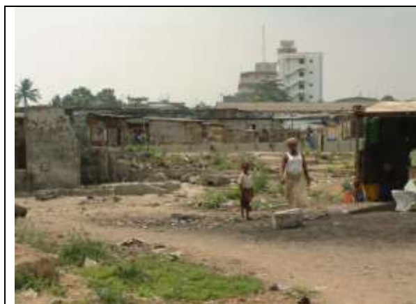
Démolition de maisons à Makoko (Nigéria), en janvier 2006.
