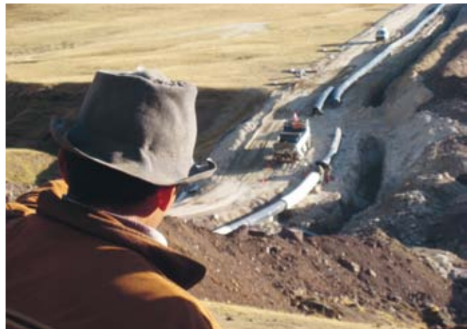
Ein Angehöriger der Gemeinschaft der Chiquintirca beobachtet die Verlegung einer Flüssiggas-Pipeline in der Region Ayacucho (Peru), September 2009.
