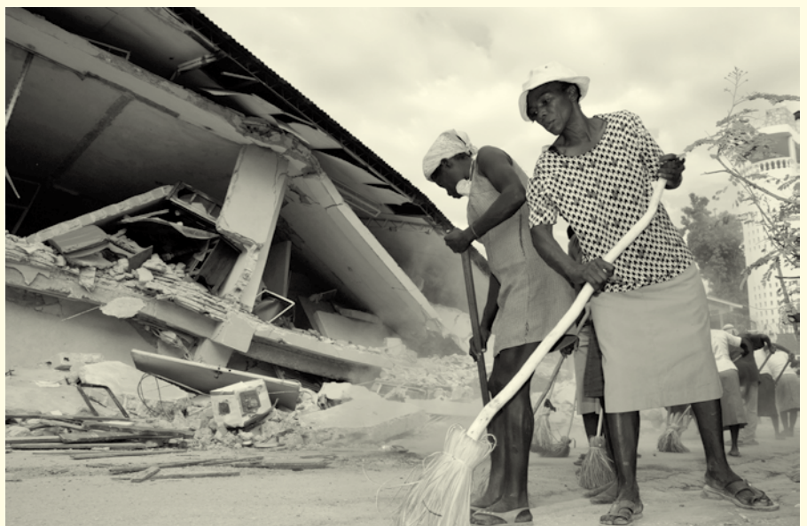
Nach dem Erdbeben in Haiti arbeiten diese Frauen in einem „Cash-for-Work“-Programm. Diese Programme unterstützen v.a. Familien, die Opfer des Erdbebens wurden, indem diese sich an Aufräumarbeiten beteiligen können und dafür Geld erhalten, Januar 2010.
