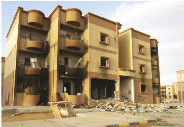
Des immeubles vides et détruits à Tawargha. © Amnesty International
