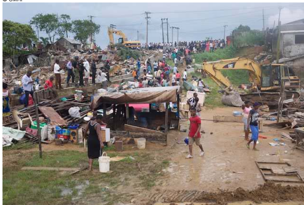
Mercredi 27 juin 2012. Premier jour des démolitions à Abonnema Wharf. Les résidents observent un bulldozer démolir des maisons au bord de l'eau.
