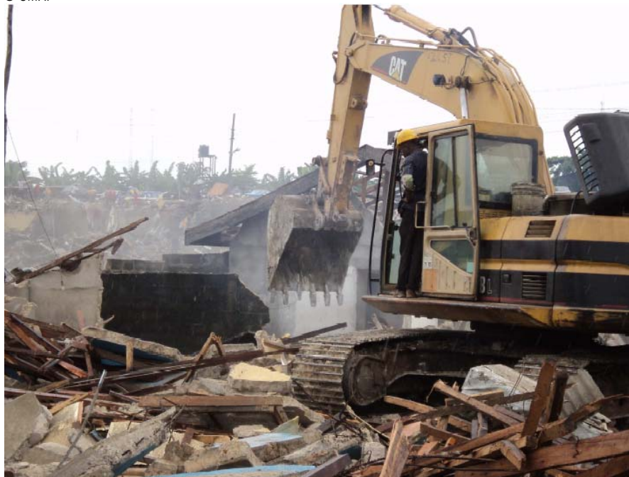
Un bulldozer démolit des maisons à Abonnema Wharf – jeudi 28 juin 2012.
