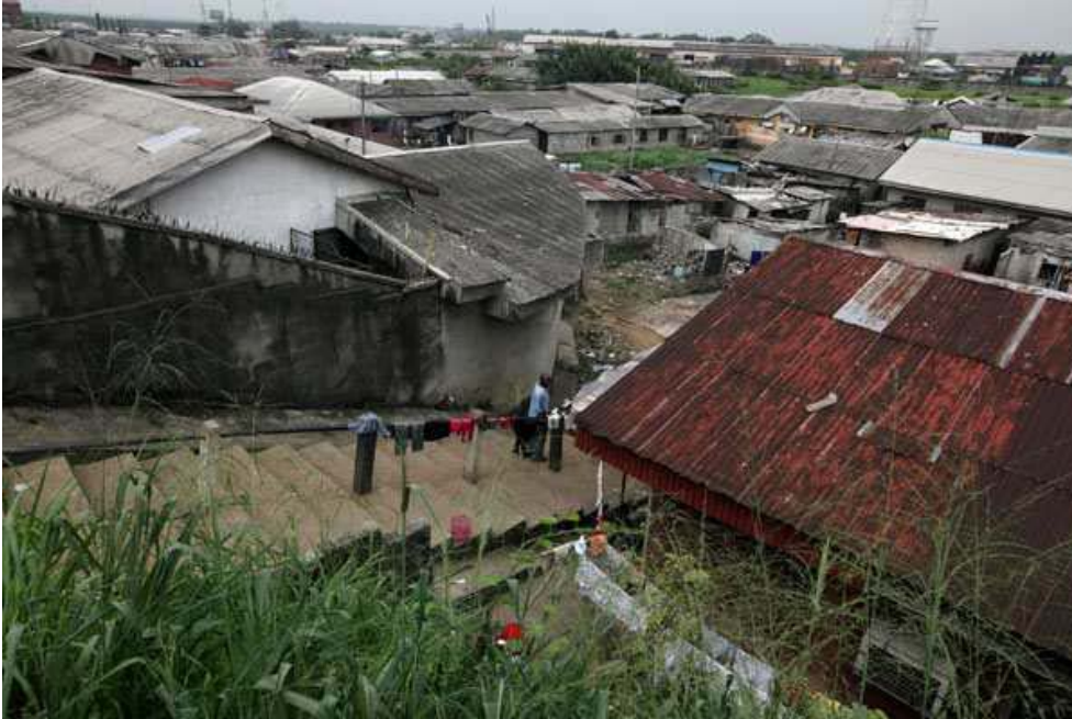
Abonnema Wharf avant la démolition – 27 avril 2011.
