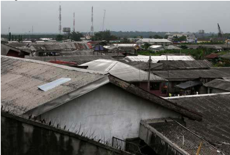
Abonnema Wharf avant la démolition – 27 avril 2011.
