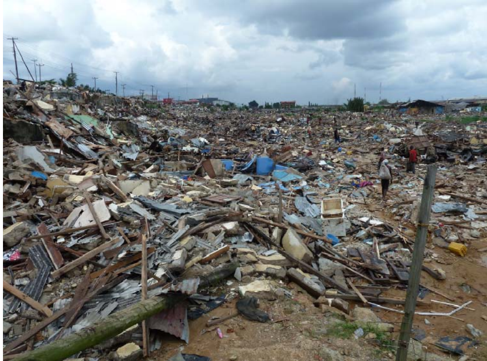
Abonnema Wharf n'est plus qu'un océan de débris après cinq jours de démolition du quartier – dimanche 1 er juillet 2012.
