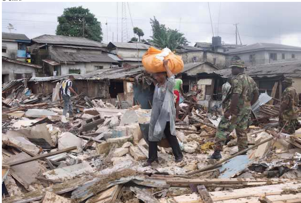
Des agents de sécurité de la Force d'intervention conjointe surveillent les démolitions d'Abonnema Wharf – mercredi 27 juin 2012.
