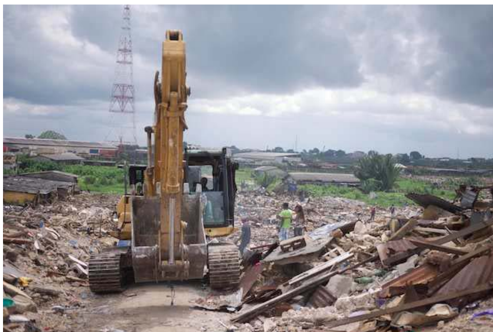
Des femmes observent un bulldozer démolir leurs maisons à Abonnema Wharf – samedi 30 juin 2012.
