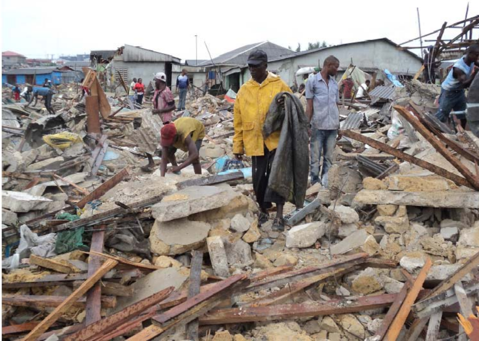
D'anciens habitants du quartier fouillent les décombres après les démolitions à Abonnema Wharf – jeudi 28 juin 2012.
