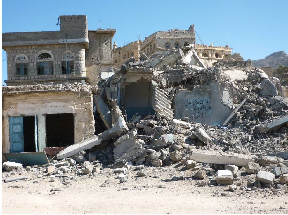
أحد المباني المدمر بالقصف الجوي في صعدة، اليمن، مارس/آذار 2010 © Private
