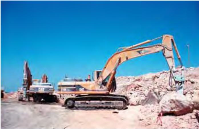
جرافة إسرائيلية تدمر أرضاً فلسطينية من أجل شق طريق لبناء الجدار في الضفة الغربية المحتلة
