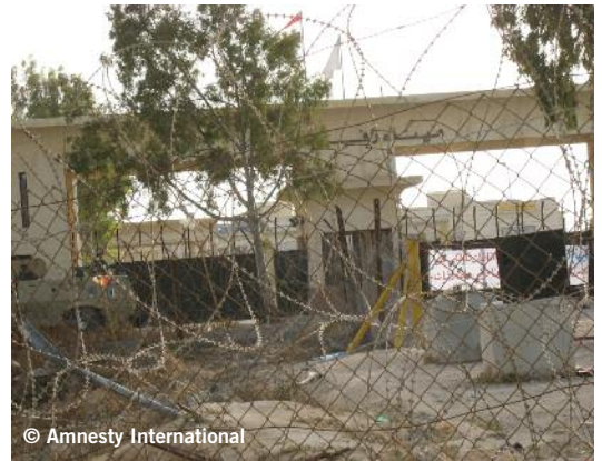
El paso fronterizo de Rafah, entre la Franja de Gaza y Egipto, en estado de abandono, mayo de 2008. Este paso fronterizo –la puerta de Gaza al mundo– lleva cerrado desde junio de 2007.
