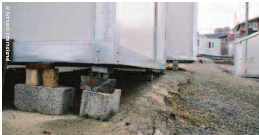
levo: Kontejneri u Orlovskom naselju, koji su obezbeđeni za porodice iseljene iz naselja ispod mosta Gazela nisu stabilni i postavljeni su suviše blizu jedan drugoga.
