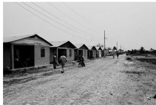
Casas del batey 5 construidas con la ayuda del padre Ruquoy © AI
