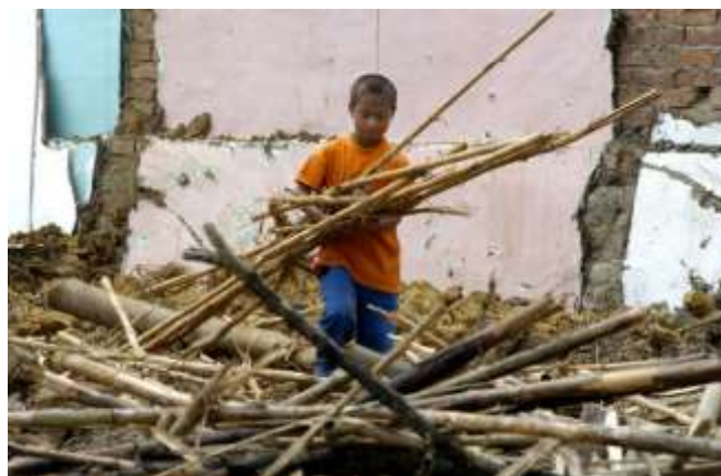
Un jeune garçon aide à dégager les décombres de la boutique de son père, détruite par les bombes des FARC, Toribío, département de Cauca, avril 2005. Plus de 20 immeubles et magasins ont été détruits au cours de cette attaque.
