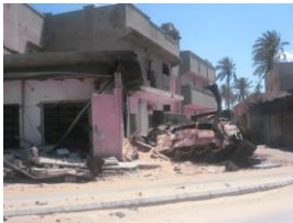
Une zone endommagée de Zawiyat al Mahjoub, à l'ouest de Misratah, 31 mai 2011.
