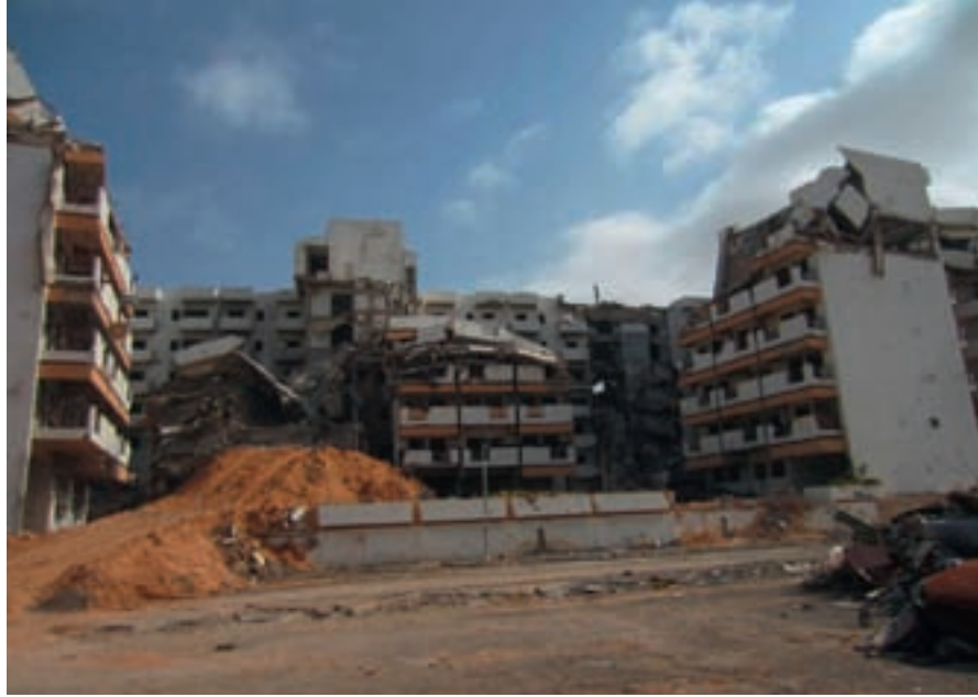
مبنى يضم شققاً سكنية قصف في 16 سبتمبر/أيلول في سرت. © Amnesty International
