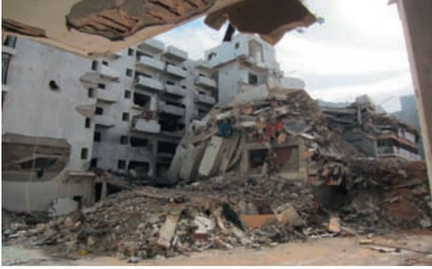
مبنى يضم شققاً سكنية قصف في 16 سبتمبر/أيلول في سرت. © Amnesty International
