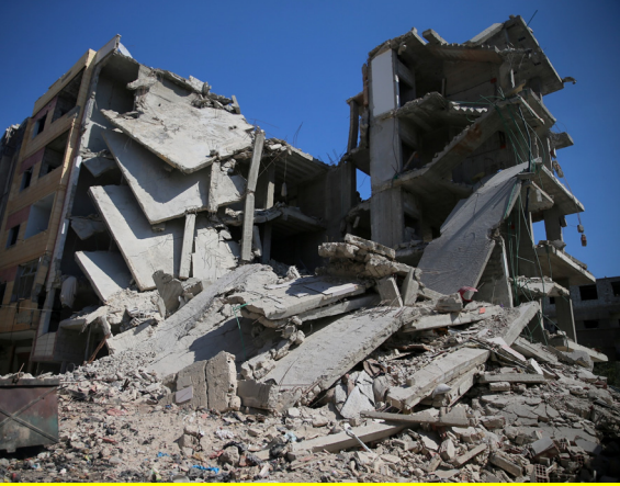
مبنى مدمر في زللكا بالغوطة الشرقية © Mohammed Abdullah
