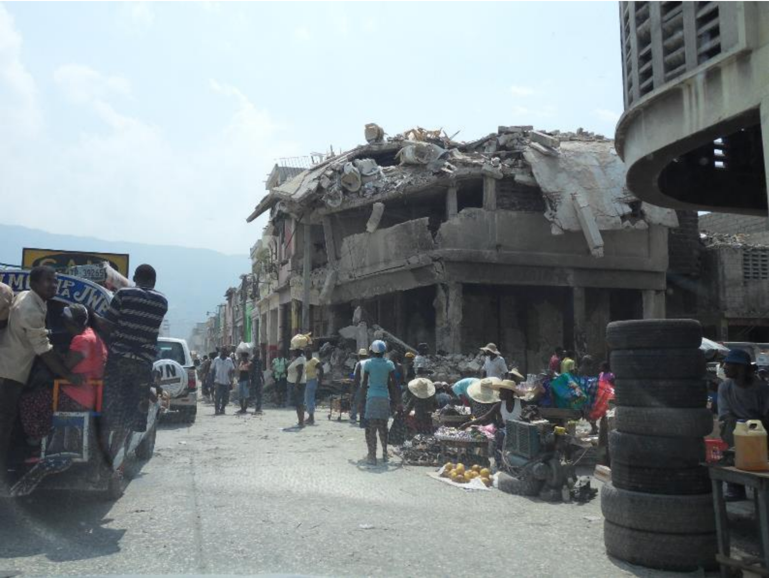
Ci-dessus : Rues du centre ville de Port-au-Prince témoignant de l'ampleur des destructions, mars 2010.
