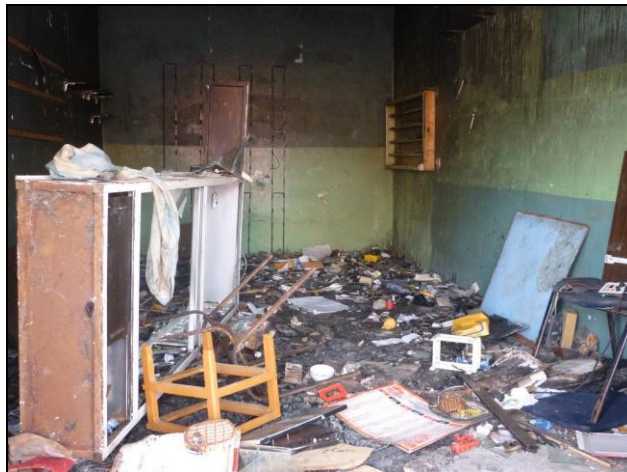
Edificio incendiado por residentes marroquíes © Amnistía Internacional
